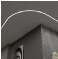
Bend right Mini bending diameter 600mm
